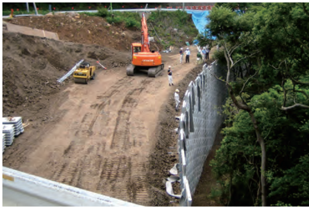
直壁盛土補強土金物
